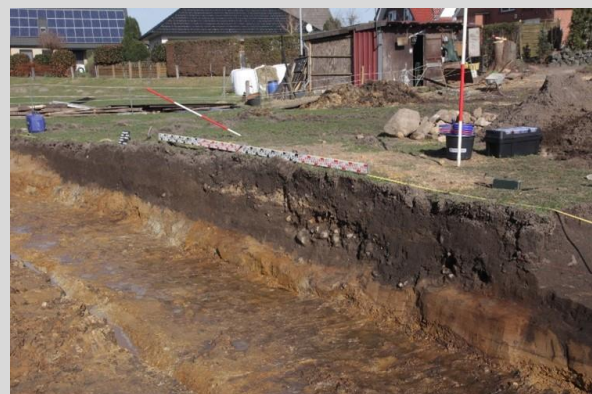
Abb. 3: Die Strassenbaugrube im Profil
